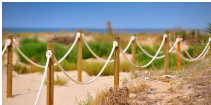
Ryc. 6. Słupki z liną (zdjęcie referencyjne): słupek drewniany, nawiercony, z przeciągniętą liną, przekrój słupka okrągły, wys. 90-100 cm, lina z materiałów naturalnych.
