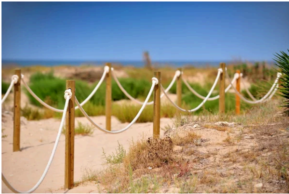
Ryc. 1. Słupki z liną - zdjęcie referencyjne - słupek drewniany nawiercony z przeciągniętą liną, przekrój słupka okrągły, wys. 90-100 cm.
